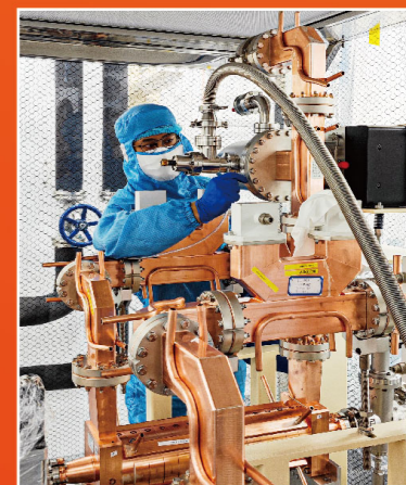
摄影-大连先进光源预研项目设备安装 乔德志 (二十五室)
