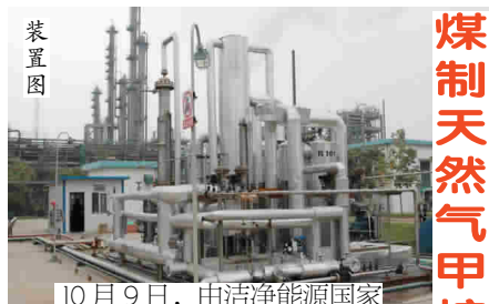
装置图 10月9日,由洁净能源国家实验室王树东研究员领导的能源环境工程研究组自行设计完成的5000立方米/天煤制天然气甲烷化工业中试装置在河南义马气化工厂气源条件下连续稳定运行超过1000小时,这是我所在煤炭洁净利用领域的又一次技术新突破。
