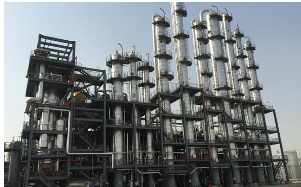
近日,由DNL0805组和DNL0807组提供催化技术和工艺包建设的3万吨/年乙醇胺临氢氨化制乙撑胺装置,在山东联盟化工股份有限公司一次投料开车成功,生产出合格的乙二胺等主副产品。
