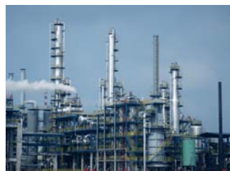
↑海南实华年产 8 万吨干气制乙苯装置
