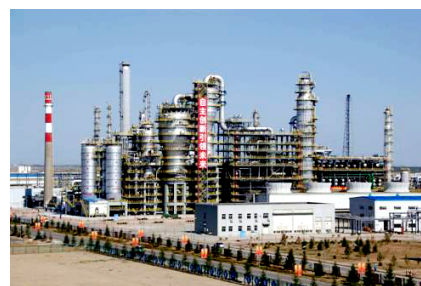
神华包头 180 万吨/年甲醇制 60 万吨/年烯烃装置
